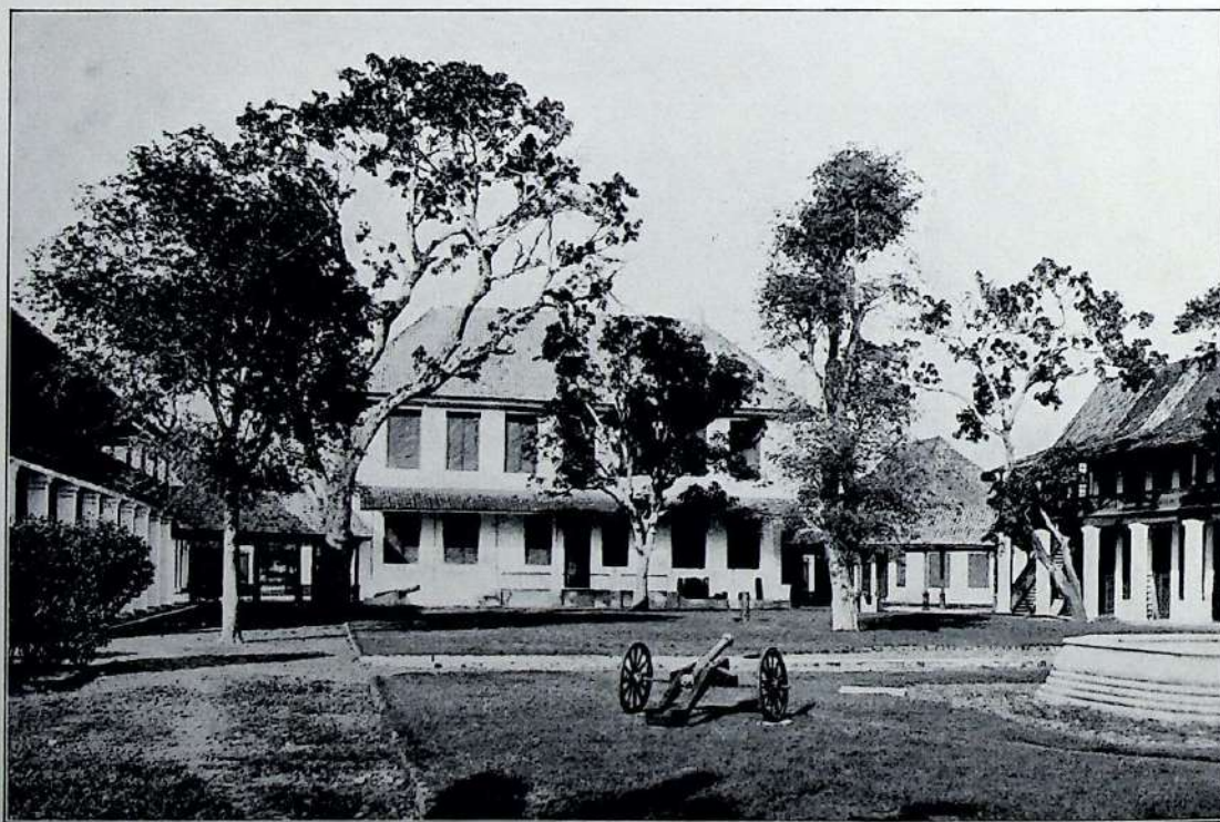
De tegenwoordige achtergevel.
